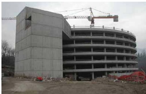
L'AUTOSILO VALMULINI DURANTE LA SUA COSTRUZIONE, IN UNA FOTO DI ARCHIVIO. SE VENISSE REALIZZATO UN METRÒ LEGGERO POTREBBE FORSE FINALMENTE RIEMPIRSI
