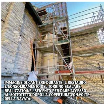
IMMAGINE DI CANTIERE DURANTE IL RESTAURO E CONSOLIDAMENTO DEL TORRINO SCALARE, REALIZZATO NEL SEICENTO PER DARE ACCESSO AL SOTTOTETTO DOPO LA COPERTURA CON VOLTE DELLA NAVATA.
