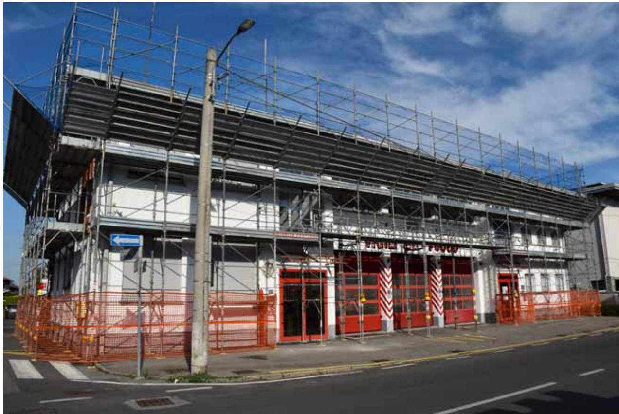
■ La caserma dei Vigili del fuoco di Lomazzo "impacchettata" per i lavori
